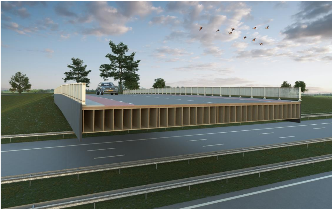
Figuur 11 - snede over biocomposieten dek
