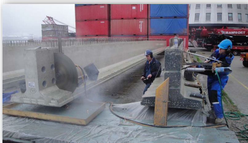
Foto-10 Voorbeeld van zagen en gezaagde prefabligger
