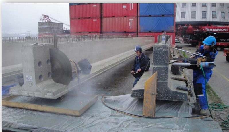
Foto-10 Voorbeeld van zagen en gezaagde prefabligger
