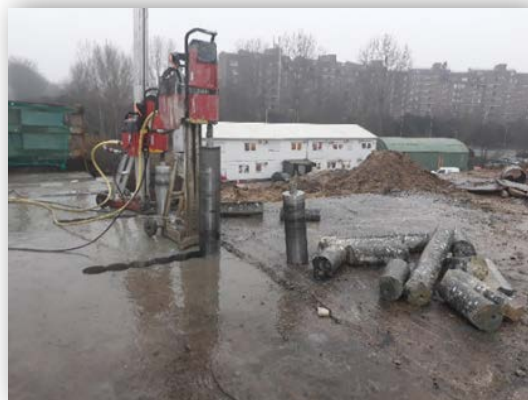
Foto-17 Doorboren einddwarsdrager
