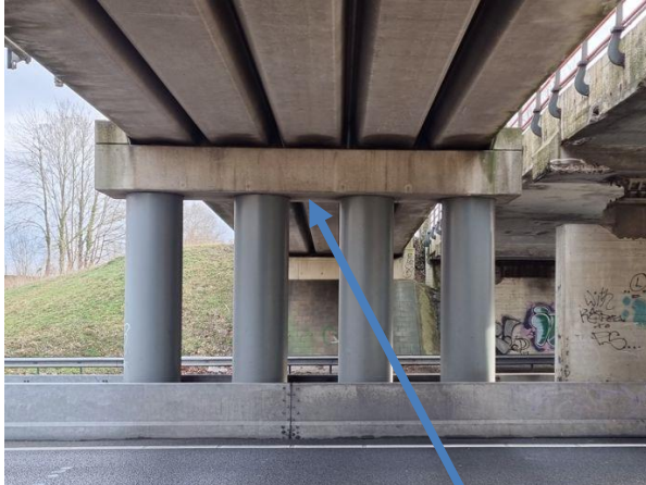
Stalen buispalen, steunpunt en kokerliggers.
