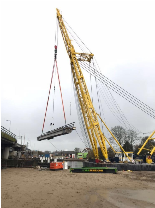
Demontage kokerliggers en randliggers Busbrug.
